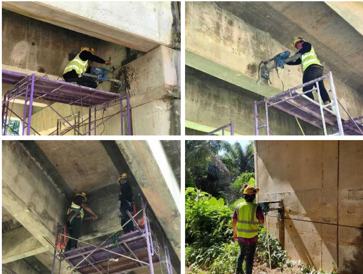
รูปที่ 11-7 รูปการทำงานเก็บวัสดุทดสอบกำลังคอนกรีต
