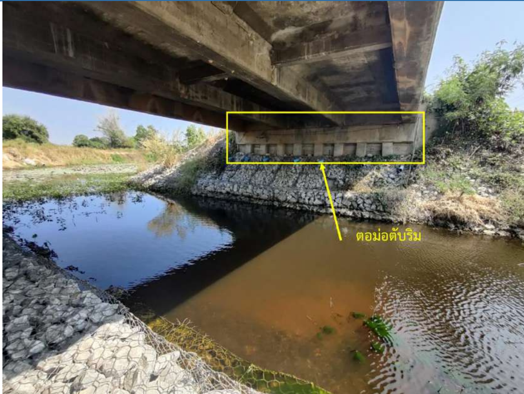
รูปที่ 16-6 ตอม่อตบริม (Abutment)
