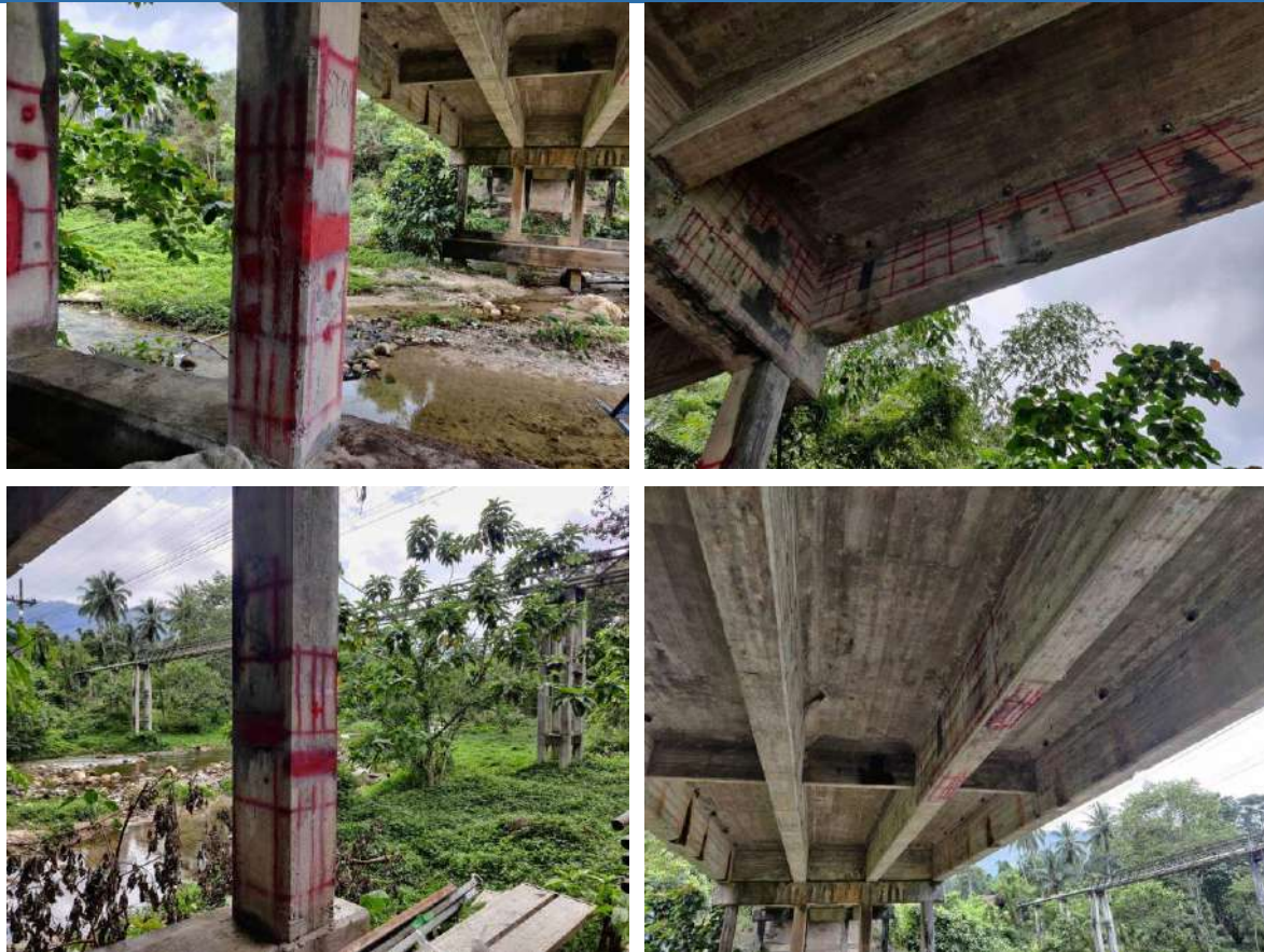
รูปที่ 10-8 รูปการซ่อมคืนสภาพจากการเก็บวัสดุทดสอบกำลังคอนกรีต
