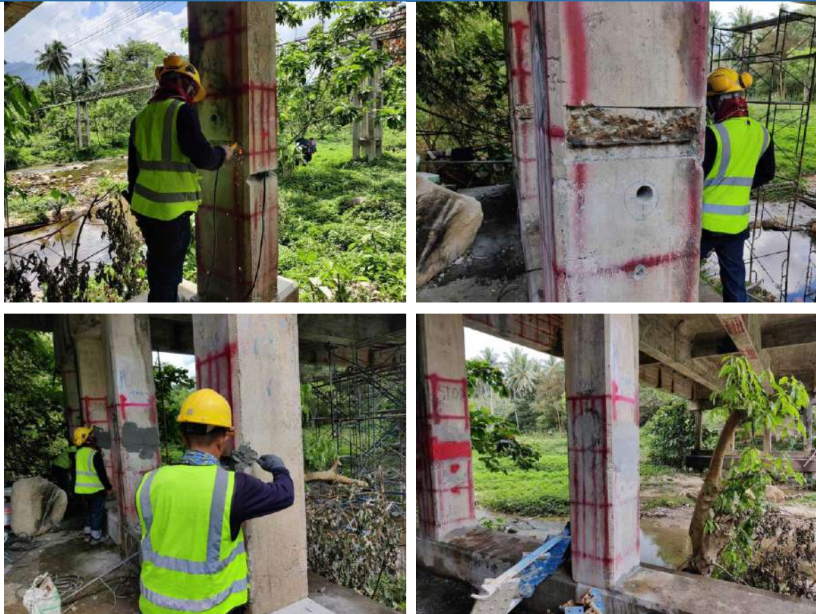
รูปที่ 10-10 รูปการซ่อมคืนสภาพจากการเก็บวัสดุทดสอบกำลังเหล็กเสริม
