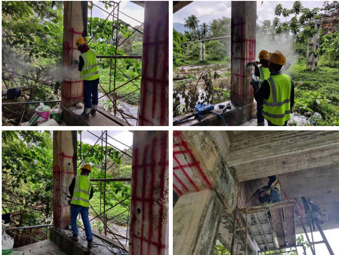
รูปที่ 10-9 รูปการทำงานเก็บวัสดุทดสอบกำลังเหล็กเสริม
