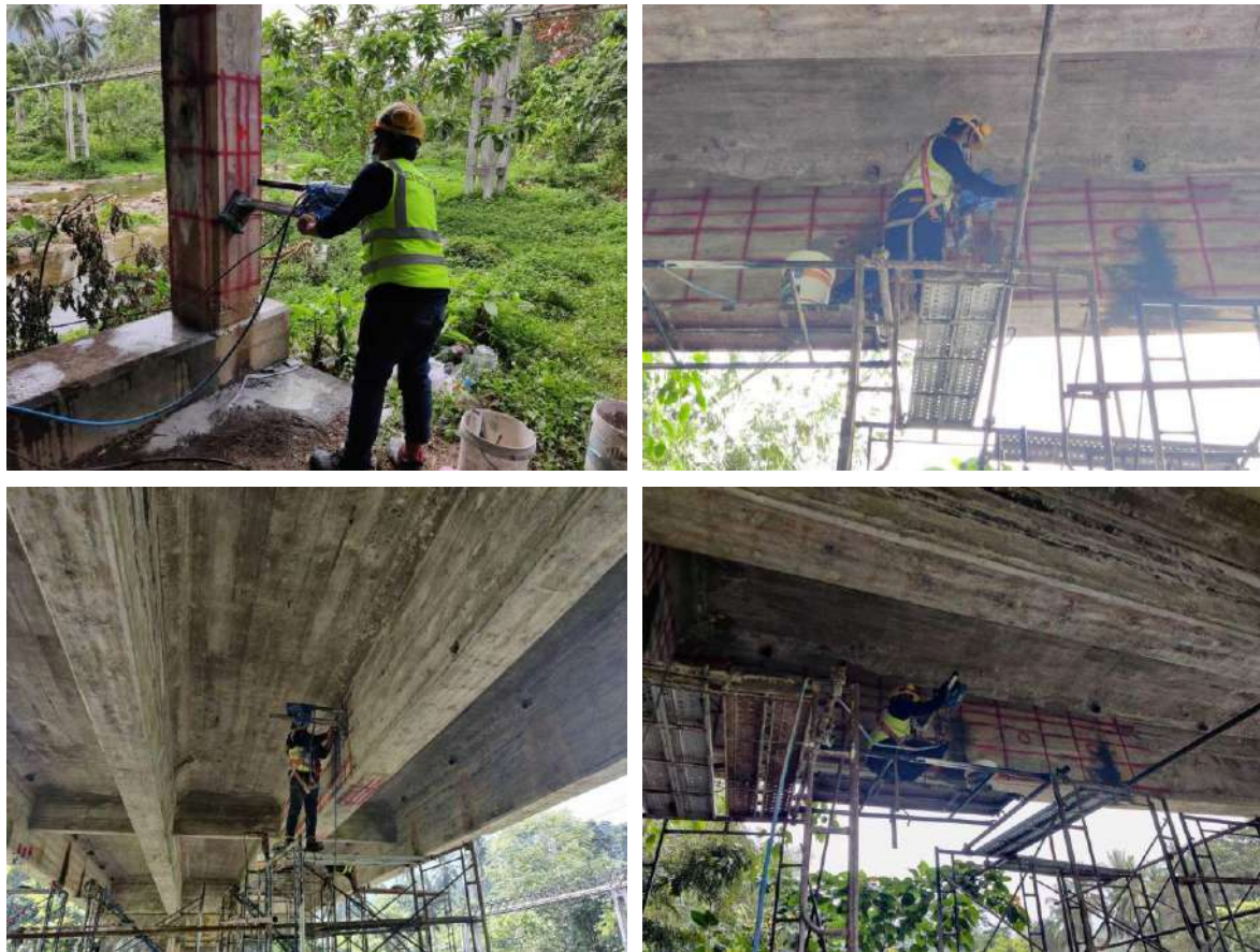
รูปที่ 10-7 รูปการทำงานเก็บวัสดุทดสอบกำลังคอนกรีต
