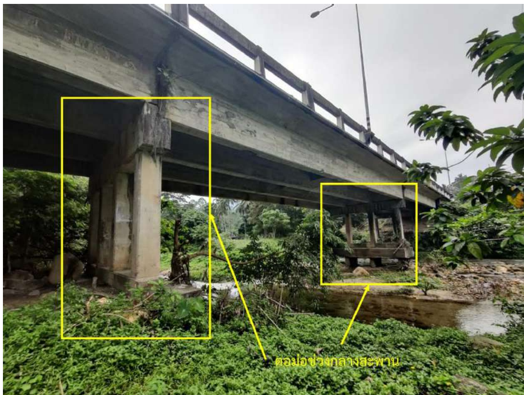
รูปที่ 16-7 ตอม่อและฐานรากช่วงกลางสะพาน
