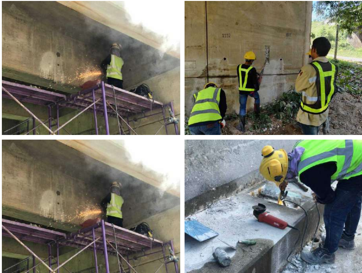
รูปที่ 11-8 รูปการทำงานเก็บวัสดุทดสอบกำลังเหล็กเสริม
